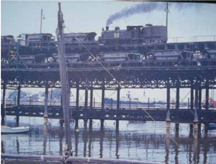
Figura 1.8. Tren de Tolvas en el cargadero del Muelle de Huelva. Autor desconocido. Fuente: Spanish Railway
