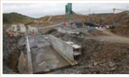
Obras de Alcolea, paralizadas en 2017.
