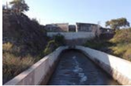
Entrada de las aguas. Túnel de San Silvestre
