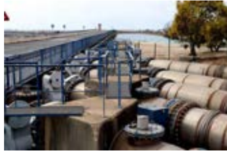
Puente Sifón de Santa Eulalia en el río Odile
