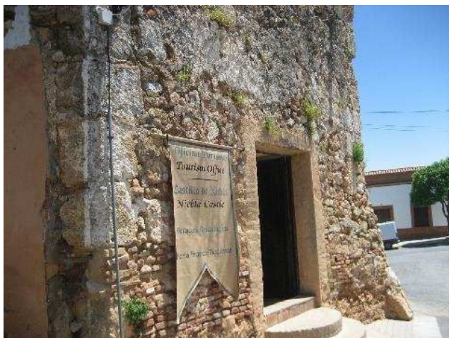
PUERTA DE ENTRADA OFICINA DE TURISMO Y ACCESO AL CASTILLO (ESPECTADORES).
