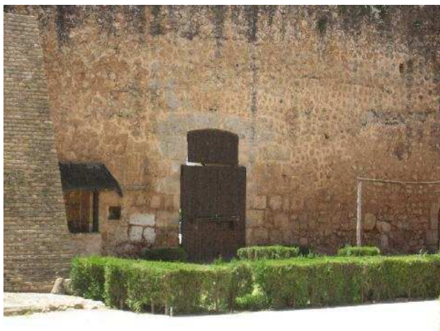
PUERTA POR DONDE CARGAN Y DESCARGAN MATERIALES DE MONTAJE
