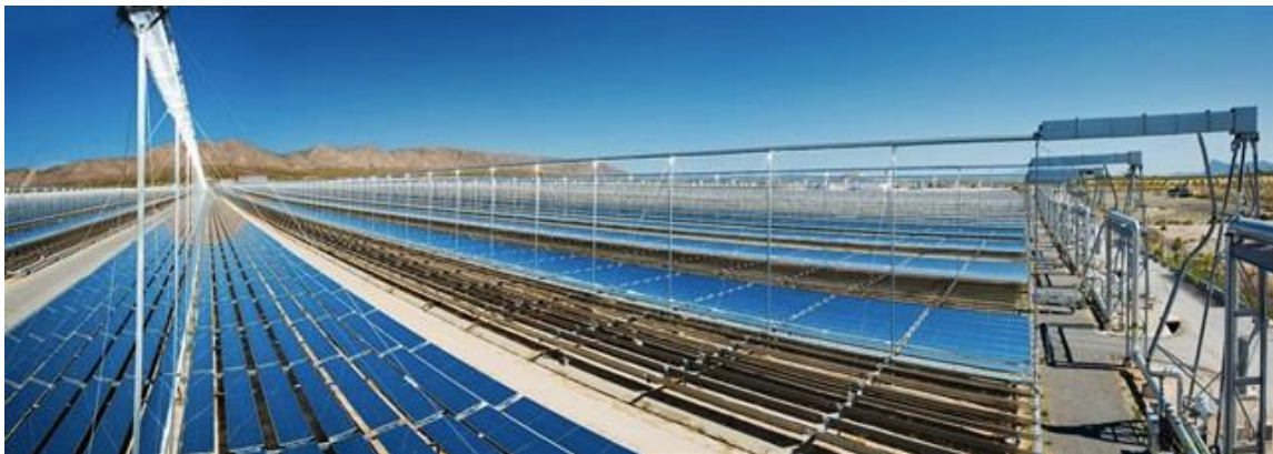
Figura 21 - Tecnologia Fresnel Linear. (Fonte: LNEG).
