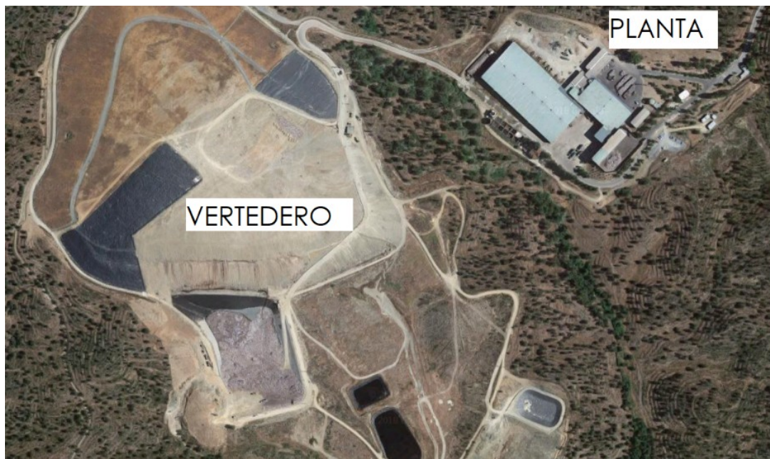
Figura 40 - Central de tratamiento de Villarasa.
