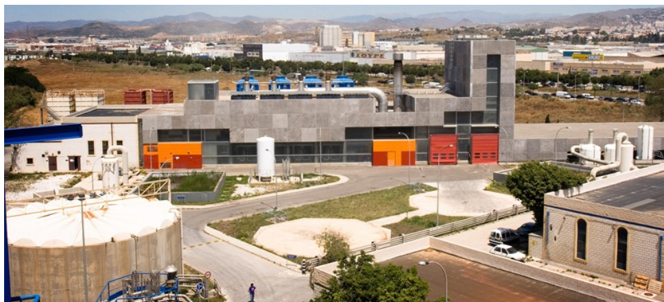
Figura 39 - EDAR de Guadalhorce. (Fuente: EMASA).
