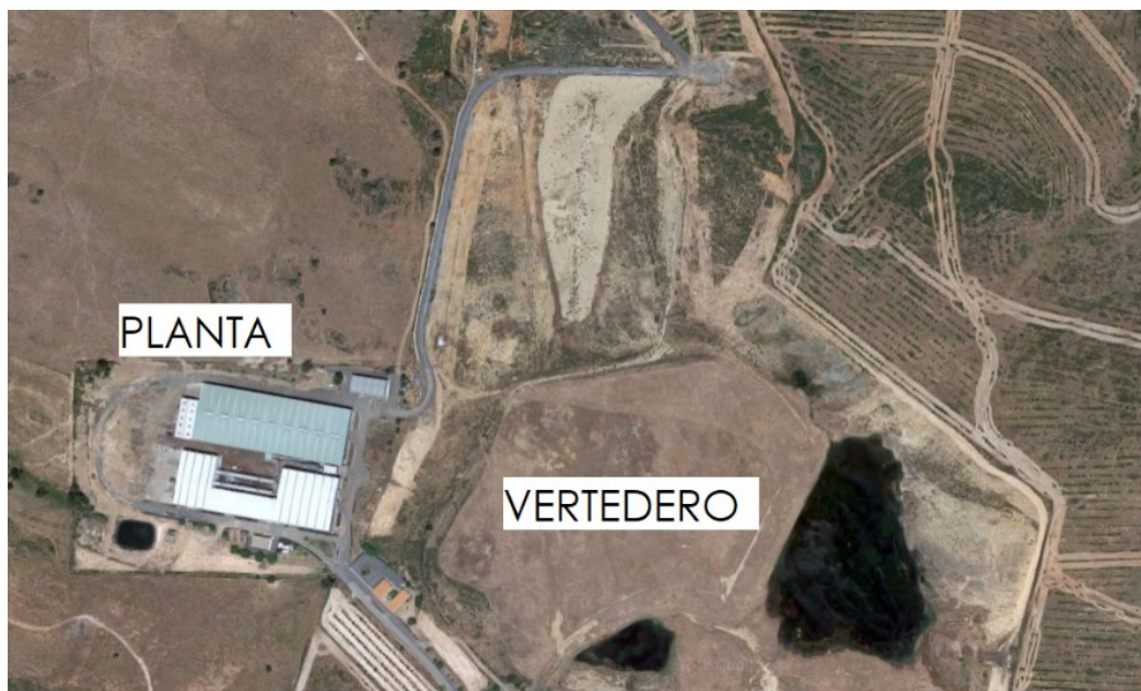
Figura 41 - Central de tratamiento de residuos domésticos del Andevalo.
