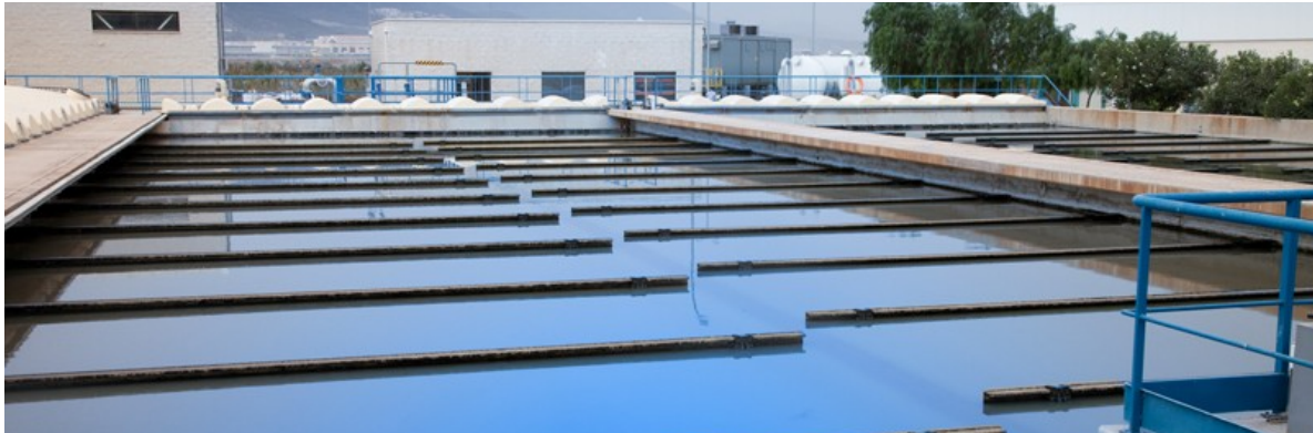
Figura 38 - Tratamiento de aguas residuales en Guadalhorce (Fuente: EMASA).
