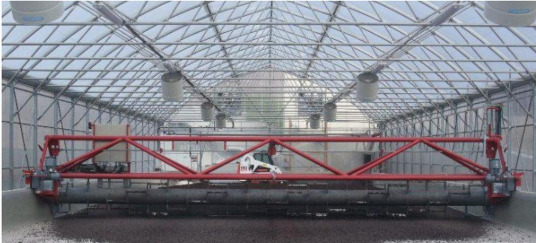
**Figura C. Sistema Heliantis en el secado de lodos de EDAR da Ponta - ilha de Porto Santo.**
