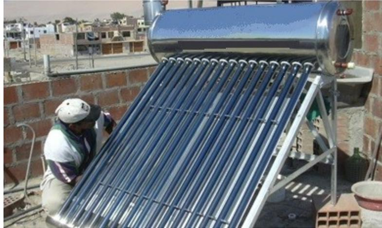
**Figura 15 - Colector de tubo de vacío.** (Fuente: LNEG).
