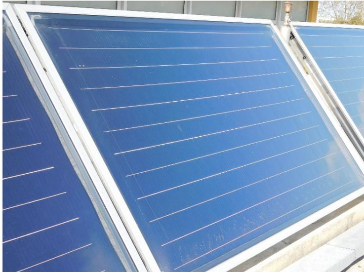
**Figura 14 - Colector solar plano con absorsor selectivo.** Fuente: LNEG
