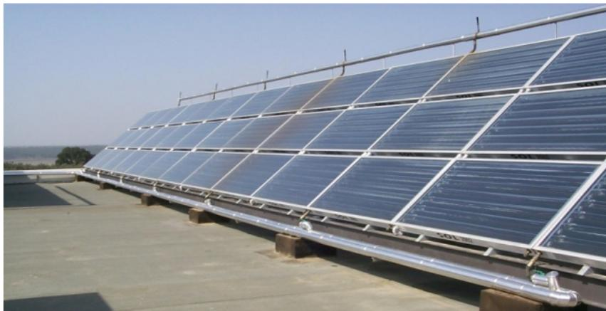
**Figura 18 - Instalación de sistema solar colectivo con utilización de colector solar del tipo CPC, en la configuración de circulación forzada.** (Fuente: LNEG).
