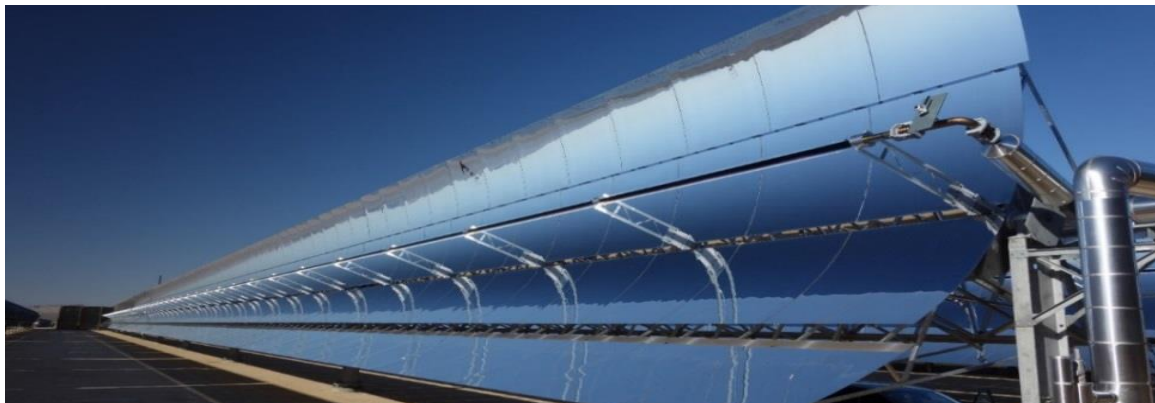
Figura 20 - Colectores cilindro parabólicos. (FLABEG, 2015).
