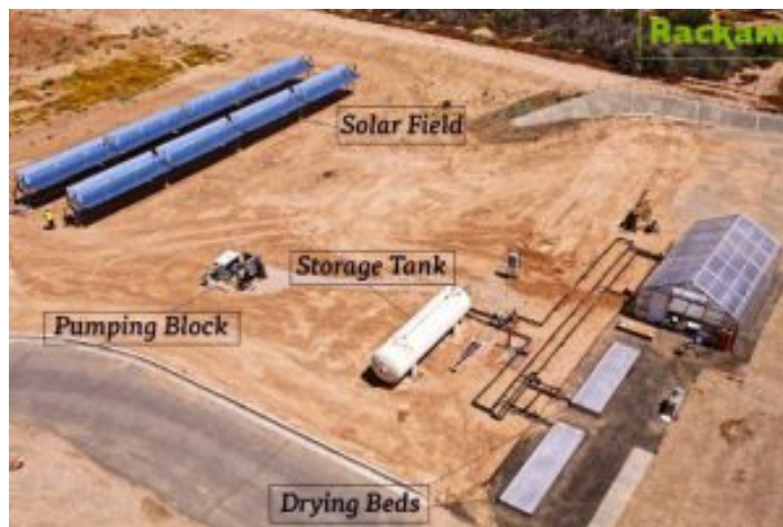
Figura A - Estación piloto para el secado de lodos de EDAR en Surprise - Arizona (USA).
