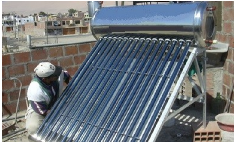
Figura 15 - Colector de tubo de vacío. (Fuente: LNEG).
