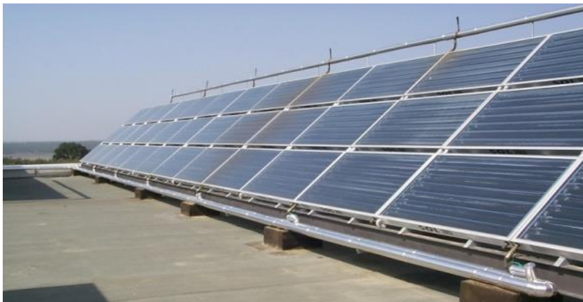
Figura 18 - Instalação de sistema solar coletivo com utilização de coletor solar do tipo CPC, na configuração de circulação forçada . (Fonte: LNEG).
