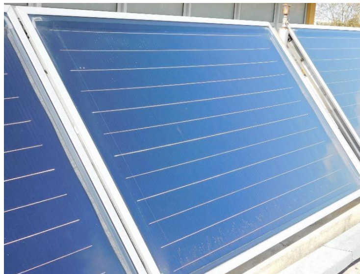
Figura 14 - Coletor solar plano com absorvedor seletivo. (Fonte: LNEG).
