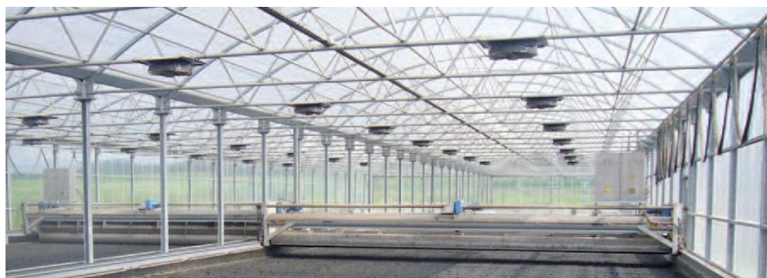
Figura 12 - Secador tipo-estufa com sistema regenerativo (HUBER Technology, 2001).
