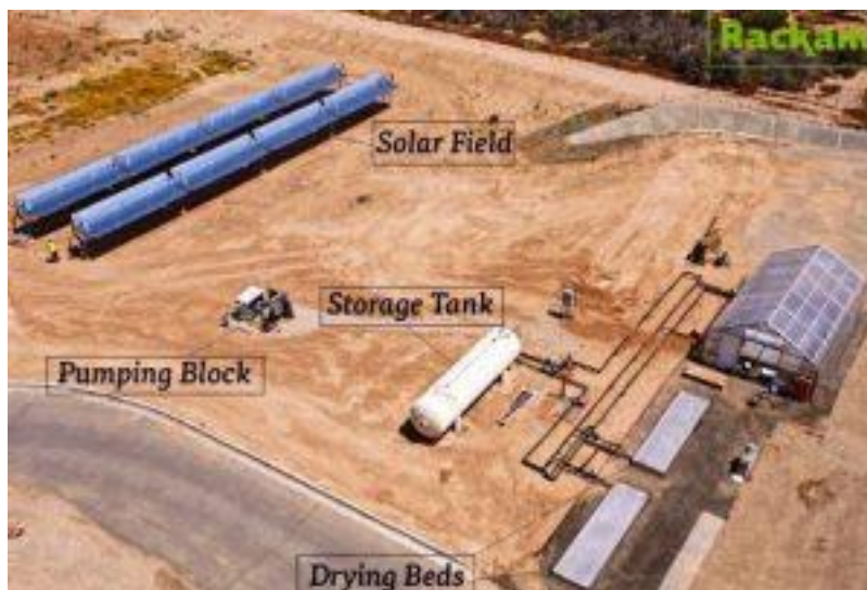
Figura A - Estação piloto para a secagem de lamas de ETAR em Surprise - Arizona (USA).
